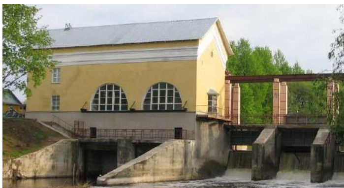
Рисунок 2.9.14 Здание Лепельской ГЭС, ул.Пушкинская
